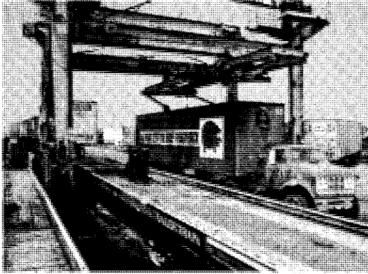
النقل المتبادل الشكل هو نقل الحمولات عن طريق أكثر من وسيلة. فالحاويات المحملة بالبضائع مثلاً يمكن تحويلها من الشاحنات الجرارة إلى عربات السكك الحديدية كما في الصورة أعلاه.
